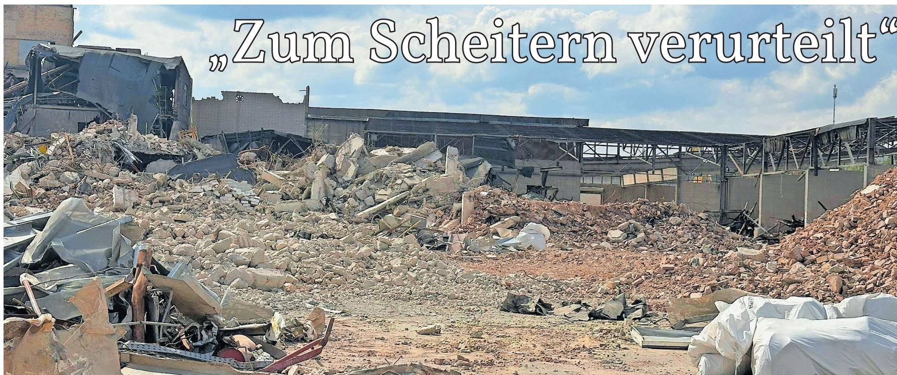
Die Abrissarbeiten auf dem ehemaligen Keramo-Gelände an der Kölner Straße sind fast abgeschlossen. Jetzt sieht die Wolf Immobilien Gruppe „die Wirtschaftlichkeit der gesamten Entwicklung des Rhenania-Quartiers“ in Gefahr. Foto: ARCHIV/ WOLF CAPITAL GMBH/RHENANIA-QUARTIER.DE
