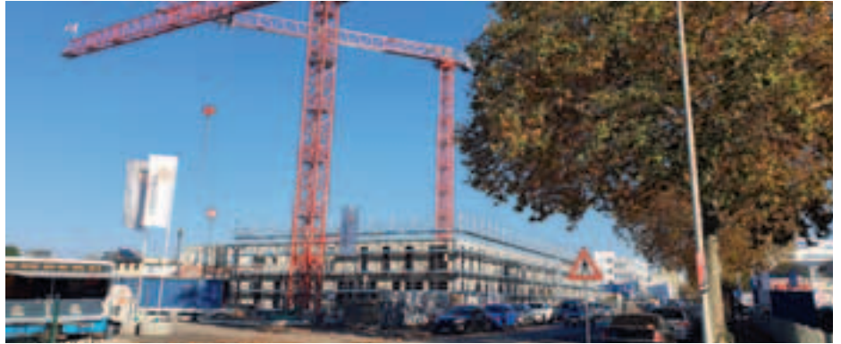
Auf der Justus-von-Liebig-Straße wird gebaut.
