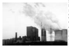
ges Netz versorgt in Aachen private Verbraucher, Büround Verwaltungsgebäude, den Dom und andere. Die gekoppelte Erzeugung von Strom und Wärme ermöglicht eine bessere Ausnutzung des Brennstoffs. Durch die Auskoppelung von Wärme im Kraftwerk Weisweiler für Aachen werden jährlich 190 Millionen Kilowattstunden Primärenergie eingespart und 50.000 Tonnen Kohlendioxid-Emissionen vermieden.
