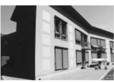
installierte die Stadt Aachen zu Demonstrationszwecken die Transparente Wärmedämmung (TWD). Ein Absorber wandelt bei dieser Technik das auf die TWD-Fassadenelemente treffende
