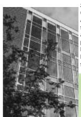
circa 90 Quadratmetern eine Fotovoltaikanlage integriert. Die in den Glasscheiben einlaminierten Solarzellen sind polykristalline Siliziumzellen. Insgesamt 3.752 Solarzellen haben eine elektrische Spitzenleistung von 4,8 Kilowatt (peak): Pro Jahr erzeugt die Anlage bis zu 2.000 Kilowattstunden Strom. Die vertikal angeordnete Solarfassade produziert weniger Strom als Dachanlagen, bei denen der Einfallswinkel der Sonnenstrahlen viel günstiger ist.
