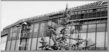
Größte Photovoltaikanlage in der Innenstadt mit 143 Modulen auf einer Fläche von 190 gm und ca. 19 KWp
