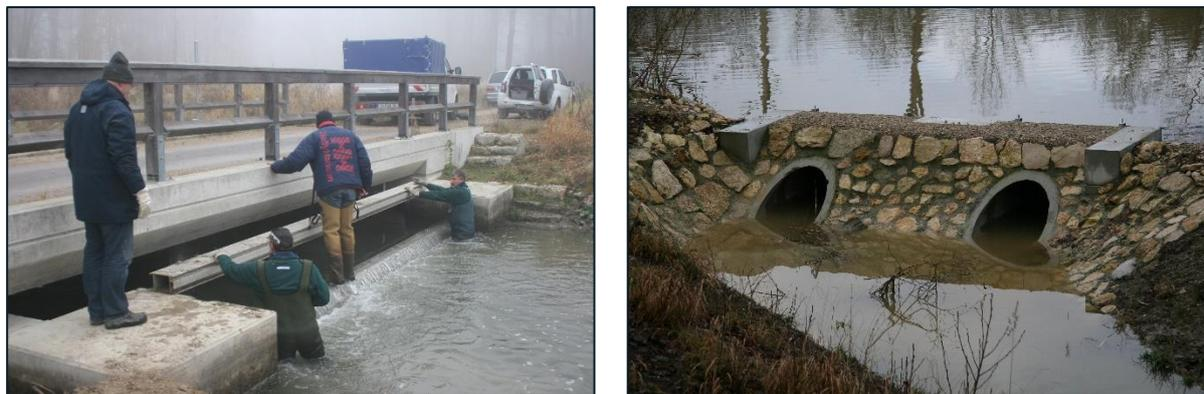
Abb. 5: rechts: Sielbauwerk bei der Alten Donau; links: Einsetzen der Dammbalken zum Absperren dieses Gewässerabschnittes (Fotos: Peter Fischer aus Cyffka et al. 2016).
