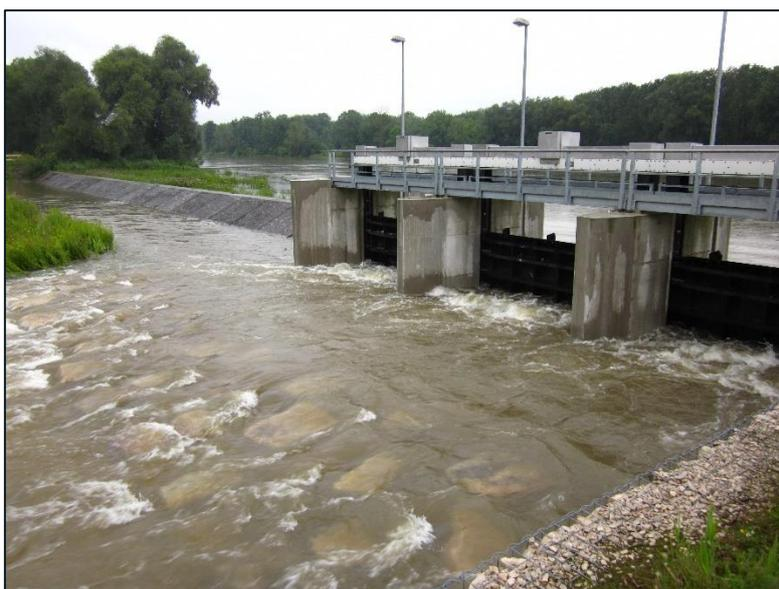
Abb. 4: Ausleitungswehr für ökologische Flutungen während der 7. ökologischen Flutung; links neben dem Ausleitungswehr für ÖF befindet sich das ca. 100 m lange Streichwehr zur Hochwasserentlastung (Foto: Bernd Cyffka)
