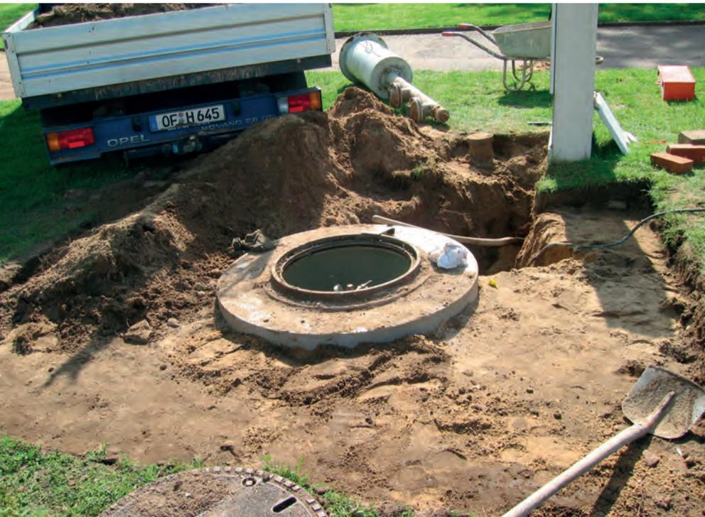
Abb. 7: Umbau eines Trinkwassernotbrunnens; Abb. 8: Fertiggestellter Trinkwassernotbrunnen.
