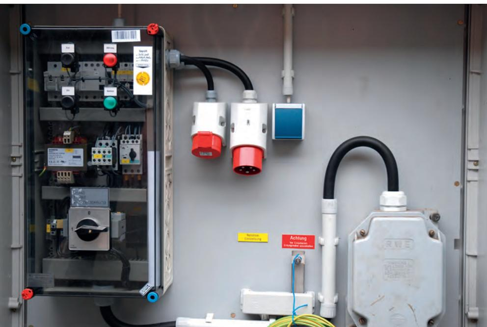
Abb. 11: Stationärer Stromanschluss.
