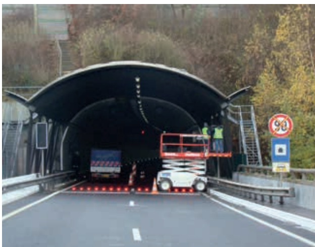
Abbildung 19: In der Fahrbahn eingebaute rote LED's Quelle: © Ponts et Chaussées, Luxemburg
