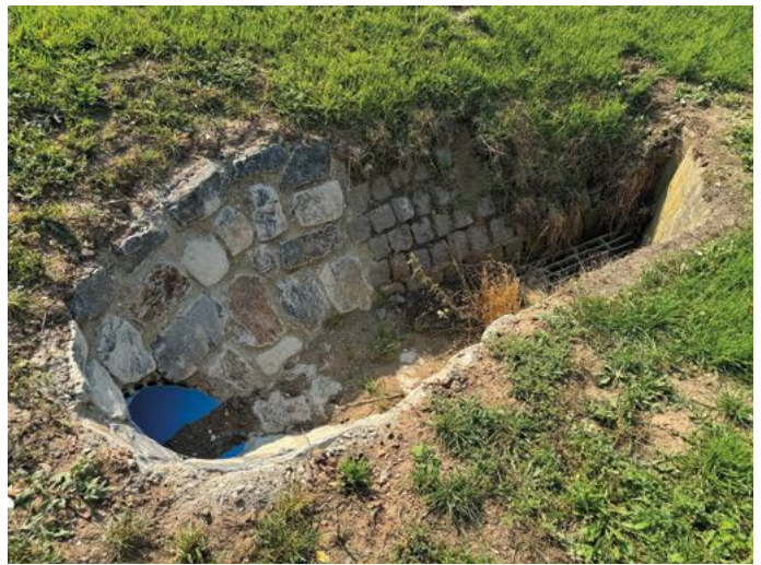
Im Zuge der Überprüfung der Wegeseitengräben im Stadtgebiet wurden – wie hier bei Juntersdorf – auch insgesamt 60 Durchlässen vergrößert.
