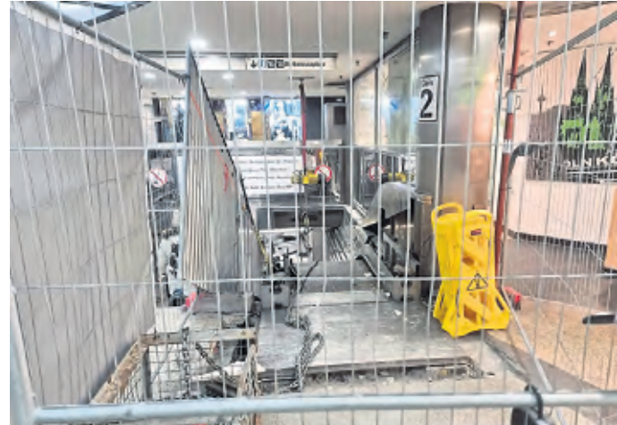
Das kennen KVB-Kunden: eine Rolltreppen-Baustelle. Foto: Marquardt
