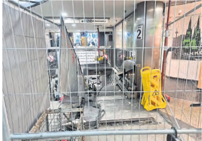
Das kennen KVB-Kunden: eine Rolltreppen-Baustelle. Foto: Marquardt
