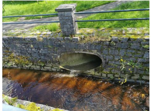
*Abb.4: Ungeklärtes Abwasser wird in den Bach geleitet.*
