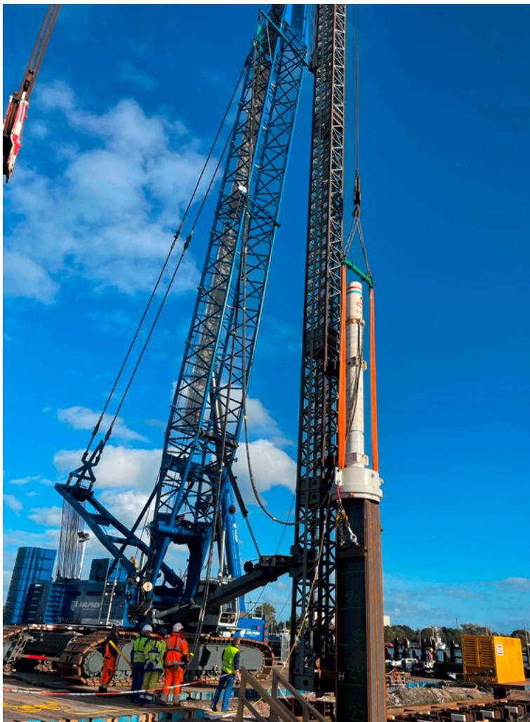
Am 12. Oktober 2023 war es dann soweit und der erste Rammschlag konnte an einer Tragbohle vollzogen werden. Im Herbst 2023 waren mehrere Großgeräte im Einsatz, um gleichzeitig an mehreren Bauabschnitten die Gründungselemente in den Untergrund einzubringen. Hier waren schwere bis schwerste Rammungen für bis zu 53 m lange Profile erforderlich, da die tragfähigen Sande erst in ca. 20 m Tiefe erreicht werden.
