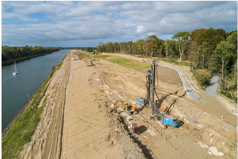
Herstellung der Sandsäulen zur Stabilisierung der Böschung in der Kurve Groß Nordsee
