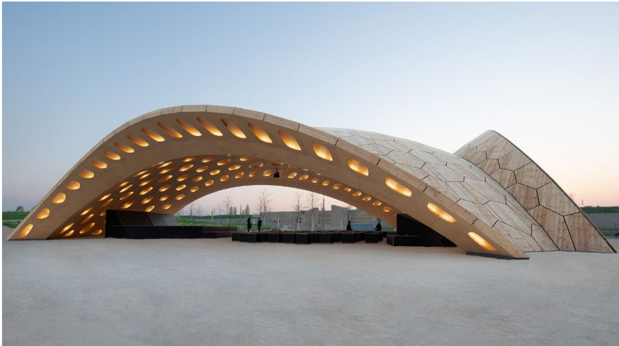
Abbildung 12: Beispiel einer Free-form Konstruktion: Holzschalenkonstruktion vom ICD und dem Institut für Tragkonstruktionen und konstruktives Entwerfen (ITKE) der Universität Stuttgart
