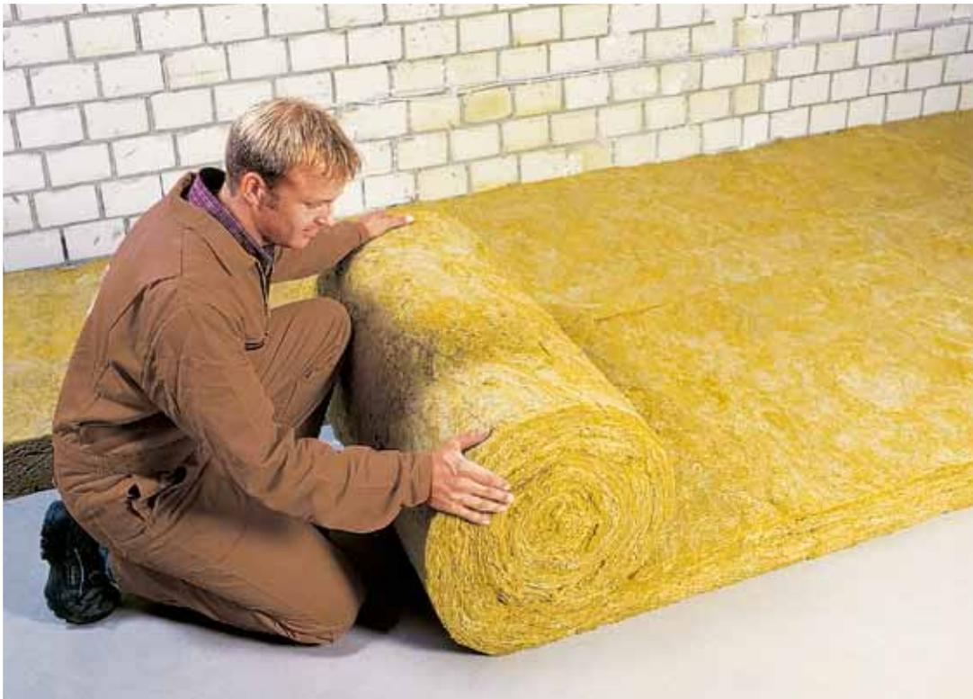
Dämmung der obersten Geschossdecke, Quelle: Deutsche Rockwool Mineralwoll GmbH & Co. OHG
