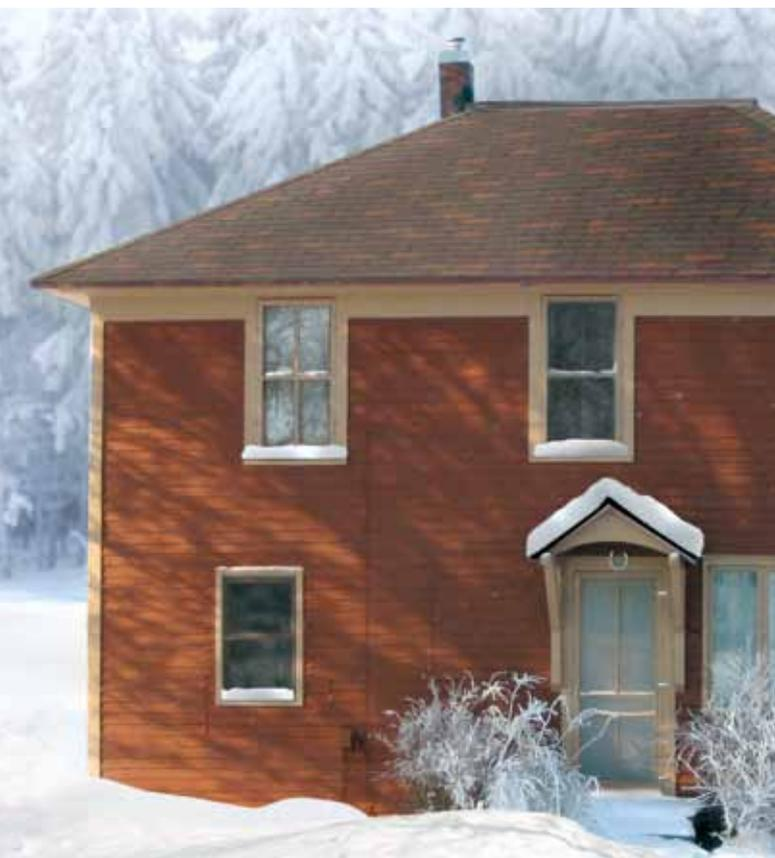
Schlecht gedämmtes Dach. Der Schnee schmilzt, da die Wärmeabgabe hoch ist.
