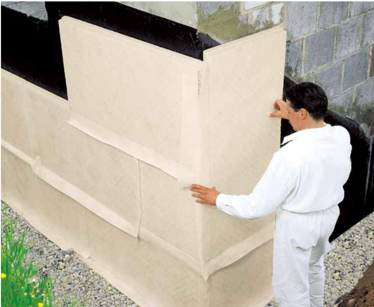
Perimeterdämmung der Kellerwände, Quelle: Rigips GmbH
