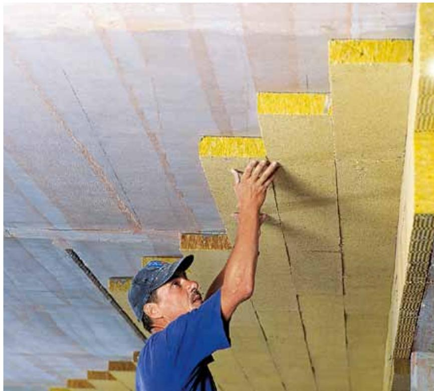
Kellerdeckendämmung von unten, Quelle: Deutsche Rockwool Mineralwoll GmbH & Co. OHG
