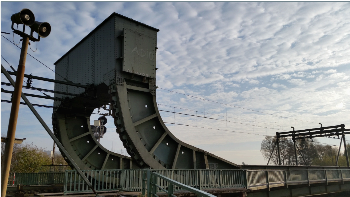
Eisenbahnrollklappbrücke über die Hunte auf der Strecke Oldenburg – Bremen. Massive Stahlkonstruktion bisher ohne Lärmschutzmaßnahmen. Quelle: Fachdienst Städtebau und Stadterneuerung, Oldenburg
