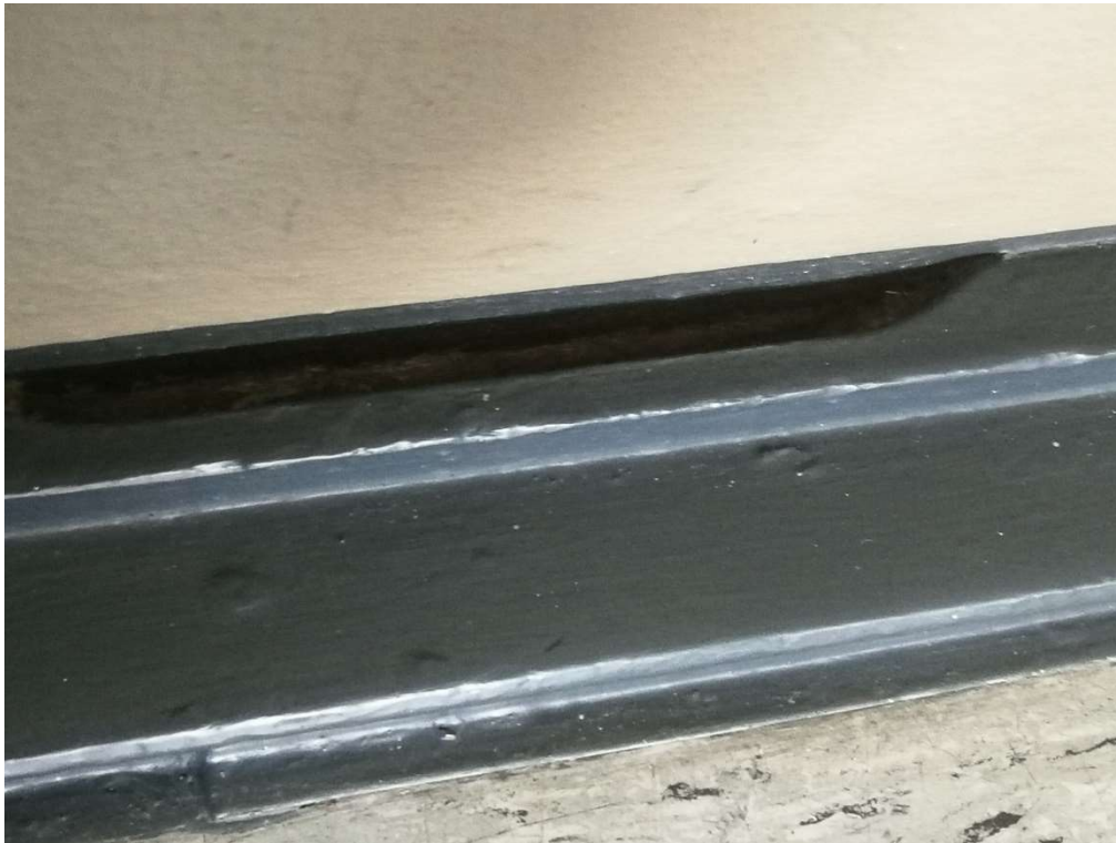
Foto 14: Lüftungsschlitze in der Fußleiste
