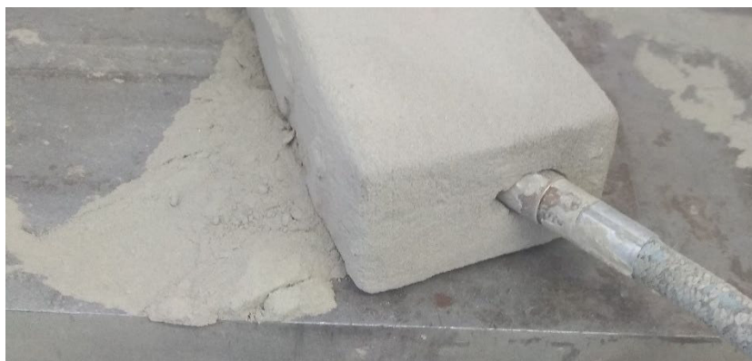
Abbildung 50: Ausblasen des Kanals durch Einführen des Druckluftschlauchs
