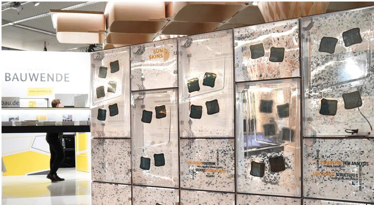
Abb. 107: Der linke Teil der Schauffassade, mit planaren Fassadenelementen, thermo-geformten Trägerelementen mit einlamierten OPV-Zellen sowie aufgedruckten Mustern unterschiedlicher Dichtigkeit.
