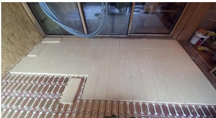
Abbildung 62: Einbau der elektrischen Fußbodenheizung und der Lehmballastplatten
