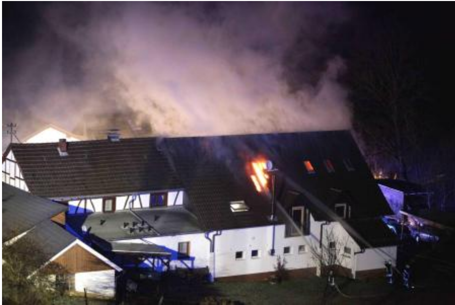
30.12.2013 Dachstuhlbrand in Komp
