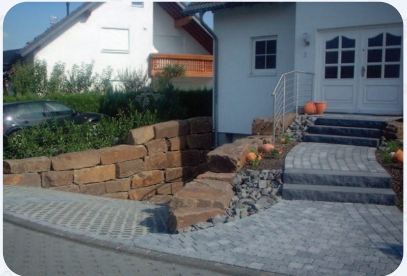
Wasserdurchlässige Befestigung auch auf den Grundstücksflächen
