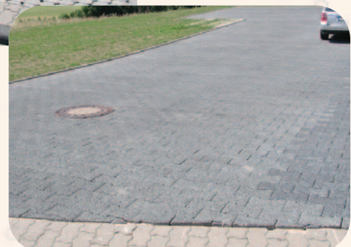
Robert-Koch-Straße, Stadt Hückeswagen: Beispiele für unterschiedliche, wasserdurchlässige Oberflächenbefestigungen
