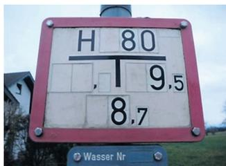
Ausgehend von dem Hinweisschild wird dieser Hydrant aus einer Wasserleitung von 80 mm Durchmesser gespeist. Der Metalldeckel befindet sich nach vorn 8,7 m und nach links 9,5 m vom Schild entfernt. Erkennbar sind Unterflurhydranten zuerst an diesem Metalldeckel.
