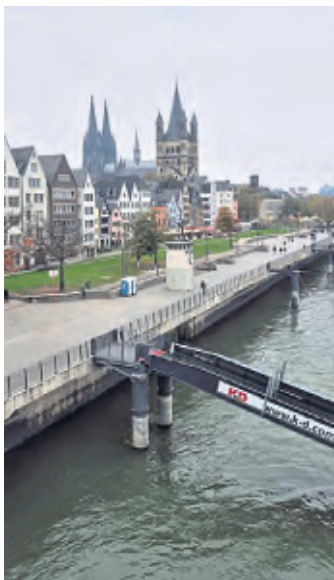
Die Bauarbeiten am Ufer sind abgeschlossen. Foto: Stadt Köln
