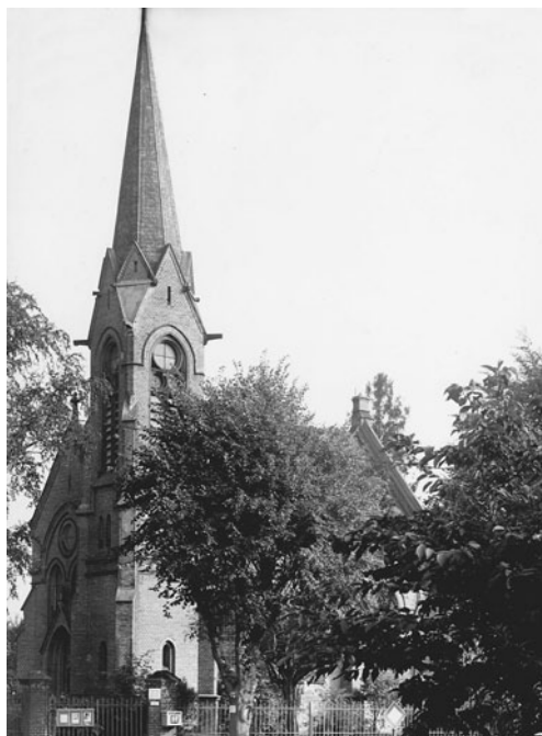
Die alte Christuskirche vor Beginn der Umbauarbeiten.
