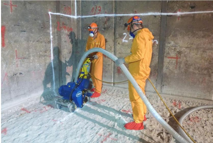
**Abb. 3.22** Fräsen des Fußbodens im Rahmen der Stilllegung des KKR (Quelle: EWN GmbH) /EWN 16/
