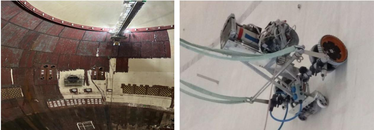
**Abb. 6.2** Das linke Bild zeigt den partiell entschichteten Sicherheitsbehälter im Kernkraftwerk Stade. Das rechte Bild zeigt den mit einem HPGe-Detektor ausgestatteten Magnetcrawler (Quelle: Brenk Systemplanung GmbH) /DEG 23/
