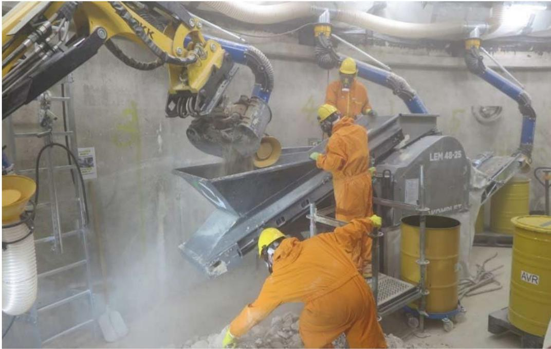
**Abb. 3.23** Backenbrecher in der AVR Anlage (Quelle: JEN Jülicher Entsorgungsgesellschaft für Nuklearanlagen mbH) /STE 23/
