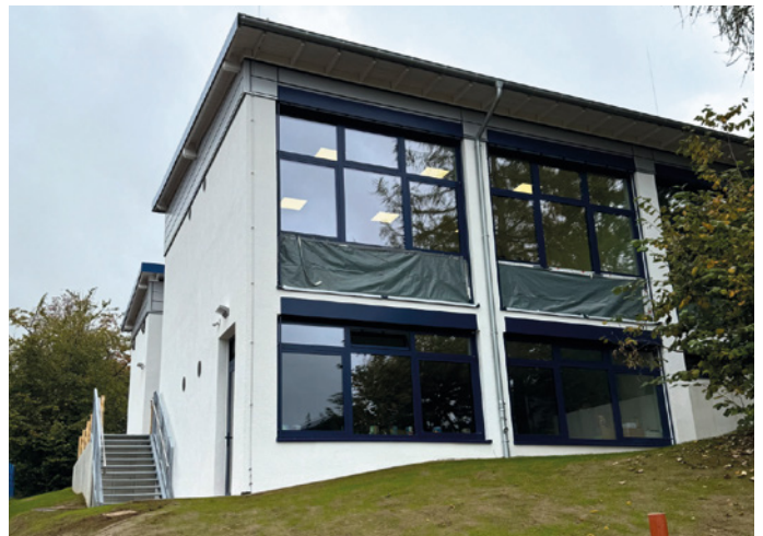
Rund 2,1 Millionen Euro hat die Stadt Zülpich in den Um- und Anbau an der Grundschule Ülpenich investiert. Foto: Stadt Zülpich / Torsten Beulen
