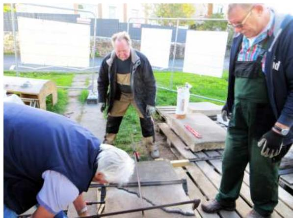
*Zusammenkleben der zerbrochenen Bodenplatte.*
