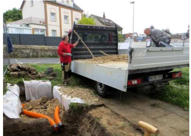
*Kieslieferung für die Rigole, für den Fundamentkies wurde ein größerer LKW benötigt.*
