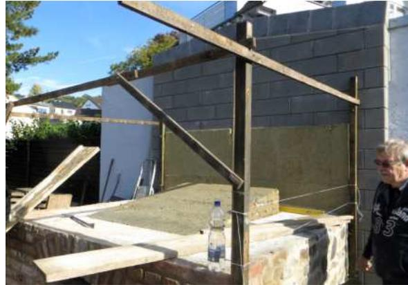
*Eine „Rampe“ sorgt später für die Schrägstellung des Backraums.*
