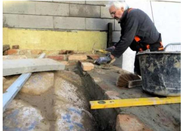
*Die Seitenwände stützen das Backraumgewölbe ab*
