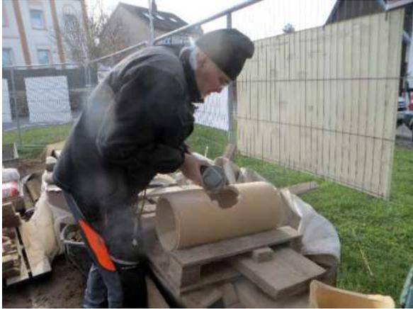
*Das Plewarohr wird für den Anschluss an den „Fuchs“ vorbereitet.*
