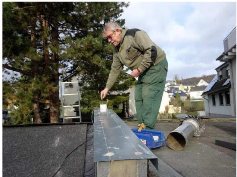
*Montage der Halterung für die Mauerabdeckung.*
