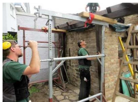
*Nach dem Einsetzen der Holzpfosten wird der gesamte Dachstuhl darauf abgesenkt.*
