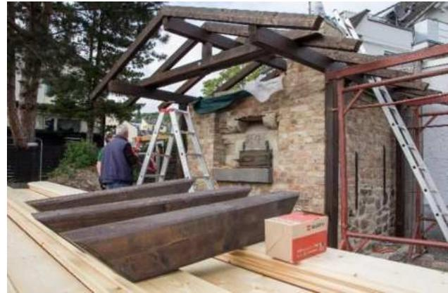
*Nachdem die abgebunden sind, wird die Verschalung auf den Balken verlegt.*
