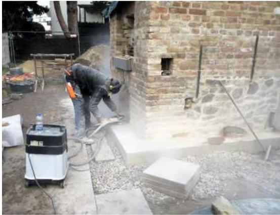
*Abschleifen der Bodenplatte.*
