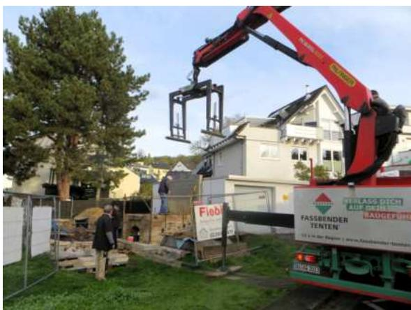
*Einbau der Bodenplatten mit dem Kranwagen.*
