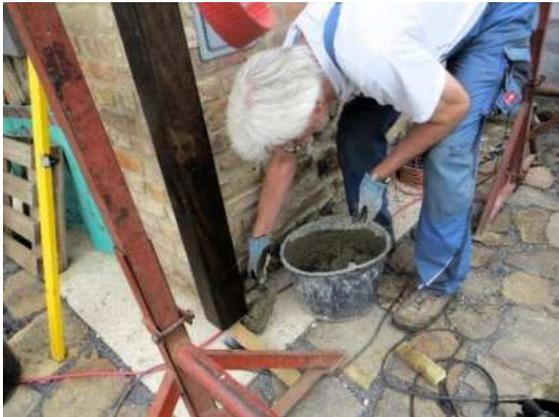
*Zum Schluss werden die Fußstützen einbetoniert.*
