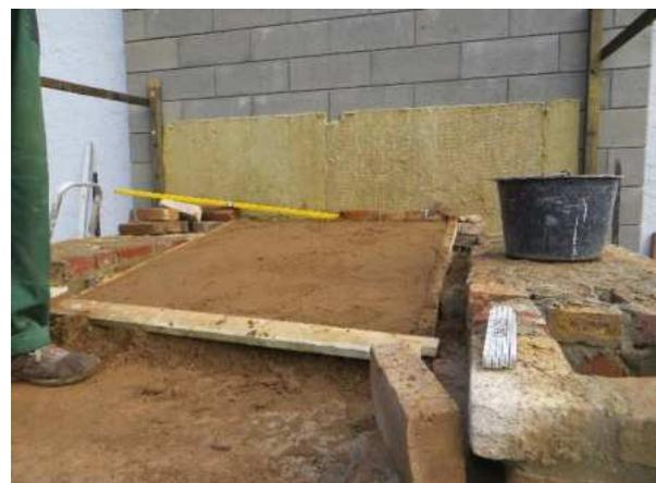
*Vorbereitung für die Verlegung der Bodenplatte des Backraums im Sandbett.*
