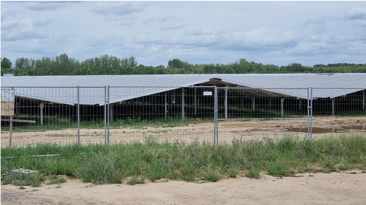
Abb. 4: Ost-West-Modulflächen des derzeit größten in Bau befindlichen Energieparks Witznitz auf rekultivierten Braunkohleflächen (Foto: D. Günnewig, Juli 2023)
