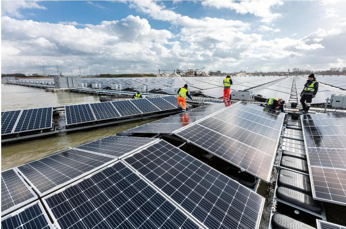
Abb. 17: Installation der Solarmodule einer schwimmenden PV-Anlage (Copyright BayWa r.e.) **Installation und Wartung (Bau und Betrieb)**
