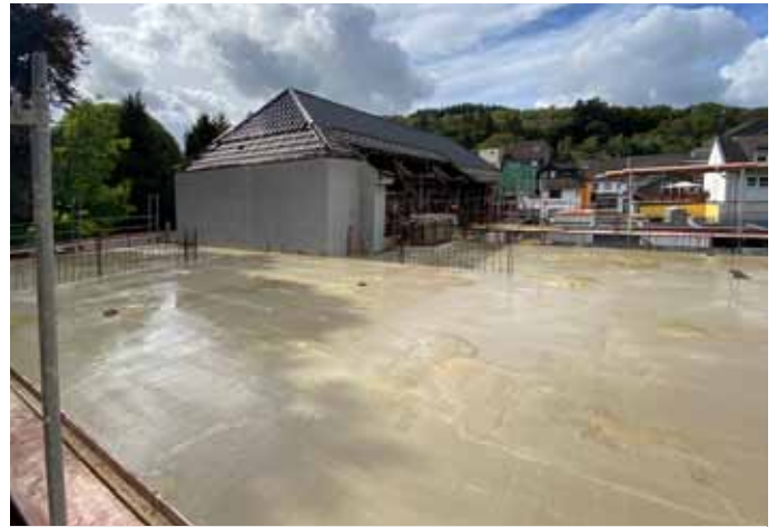
Blick auf die Betondecke des Neubaus und den Altbau. (© Stadt Schleiden / Felix Bettinger)
