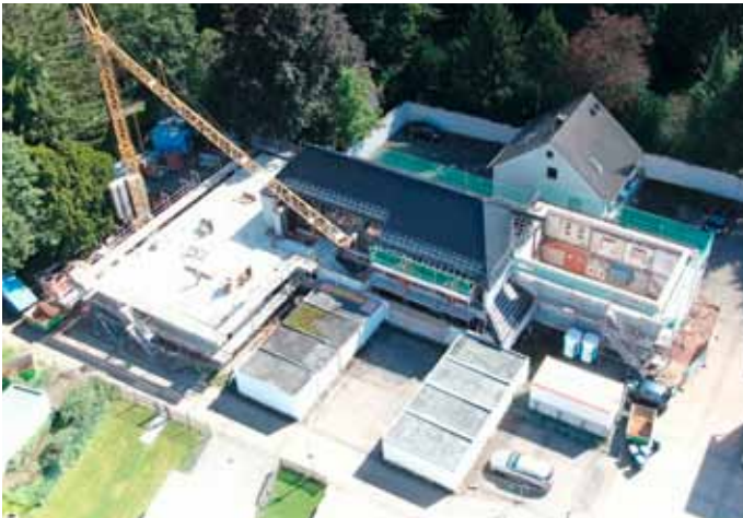
Blick auf die Baustelle aus der Luft. (© Stadt Schleiden / Waldemar Brost)
