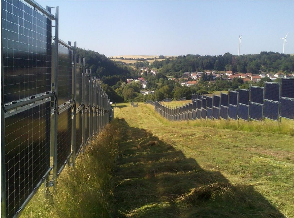
Abb. 5: Vertikale bifaciale PV-Module von Next2Sun in hügeligem Gelände. (© IZES)
