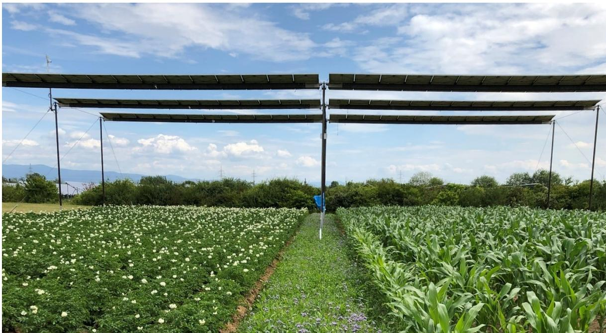
Abb. 21: Agri-Photovoltaik-Anlage mit integrierten Blühstreifen. (© Krinner Carport GmbH)
