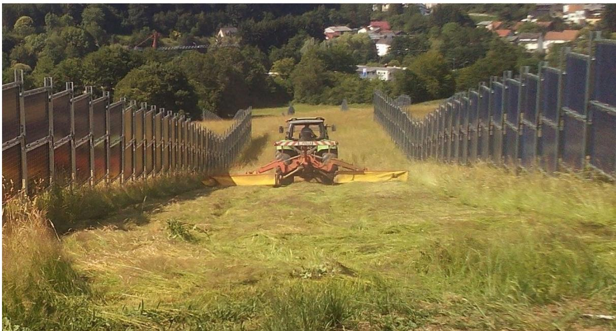
Abb. 3: Arbeitsbreite des Mähwerks gibt den Reihenabstand für die Module vor. (© IZES)
