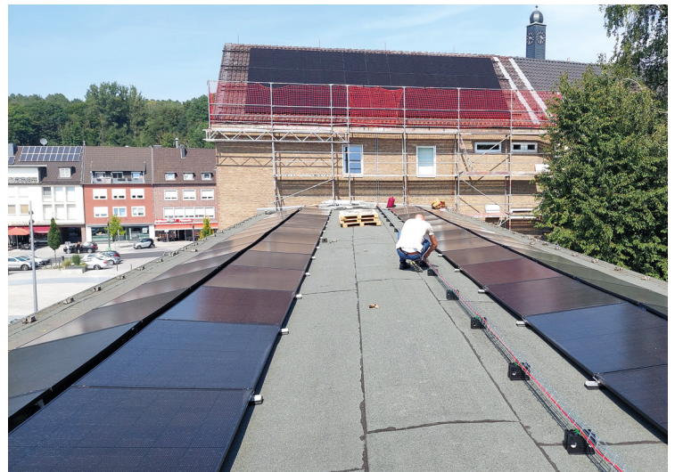
Montage der PV-Module auf dem Rathausdach am 31. Juli 2024
