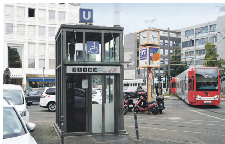
Mit dem Alter nimmt auch die Störanfälligkeit der Aufzüge zu. Die KVB saniert im Schnitt sechs Anlagen im Jahr.
