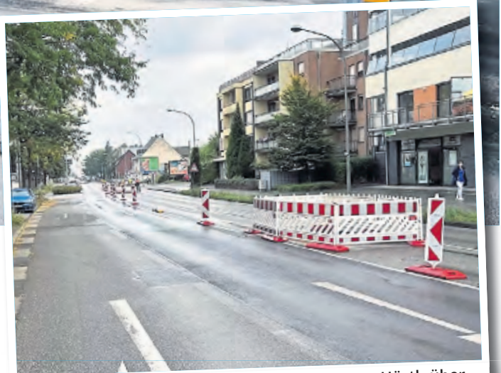
Absperrungen verhindern das Durchfahren von Hürth über die Luxemburger Straße. Foto: Schwamborn
