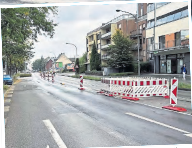
Absperrungen verhindern das Durchfahren von Hürth über die Luxemburger Straße. Foto: Schwamborn
