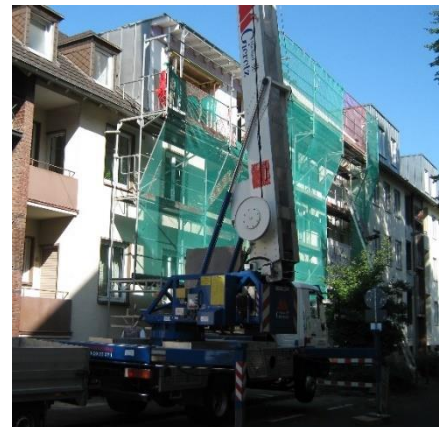
Dachaufstockung auf WEG
