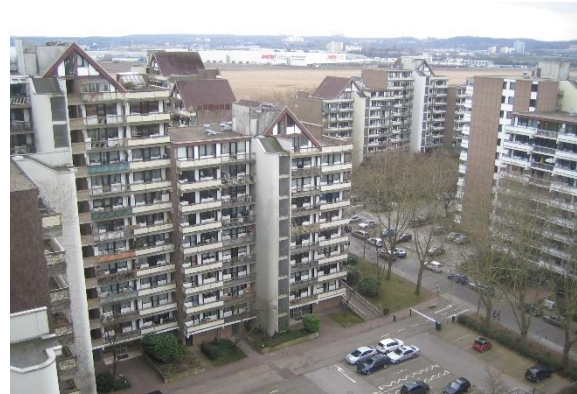
Wohnpark Köln-Weiden, Baujahr Mitte der 70er
