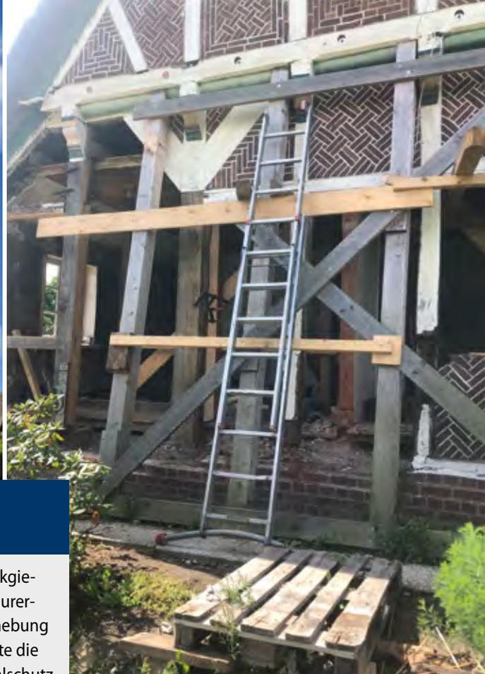
*Bei der Fassadensanierung wurde auch die Statik korrigiert.*
