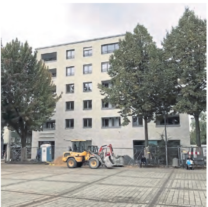
Das Bauvorhaben am Poller Marktplatz steht vor der Fertigstellung, am Platz selbst wurde aber nichts verändert.
