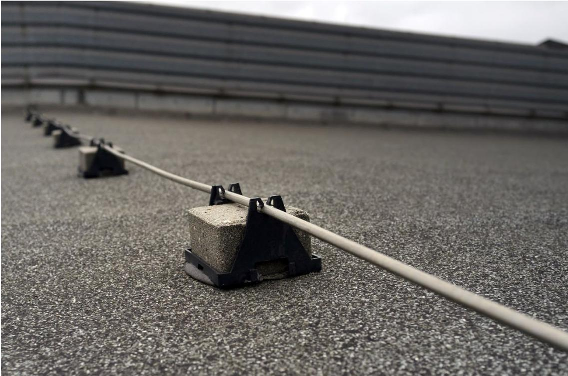
**Abb. 3.17** Überspannungsableiter/Blitzableiter, Quelle: Alis Leonte/Shutterstock.com
