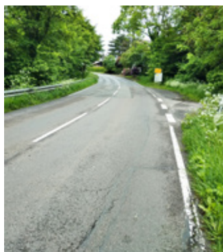
Die K 58 bei Morsbach-Lichtenberg wird großflächig saniert. Foto: OBK
