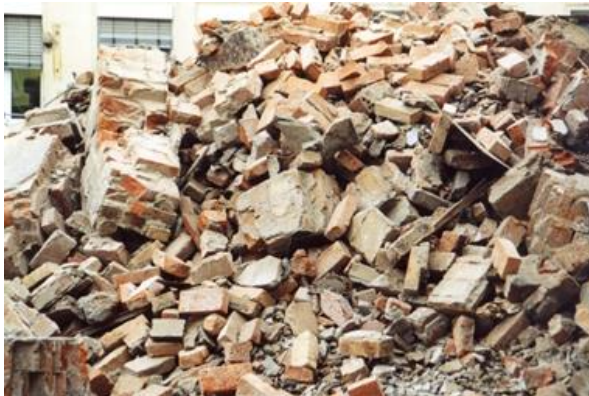
Abbildung 1: Gemischter Mauerwerksbruch auf der Baustelle
