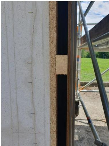
5. Hinterlüftung PV-Fassade
