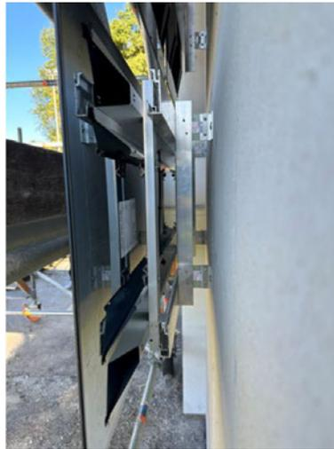
6. Unterkonstruktion PV
