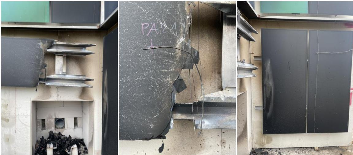
Abbildung 134: Herabgefallene Teile und Splitter der PV-Module
