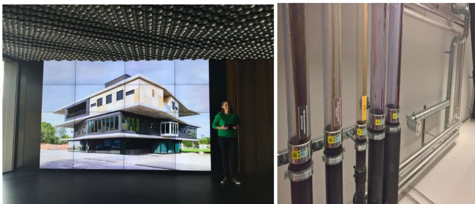
Abbildung 48: Forschungsgebäude NEST und getrennte Ableitung von unterschiedlichen Abwasserteilströmen (Quelle: Hörnlein).
