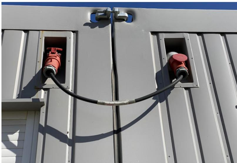
Abbildung 51: Steckverbindung Energieversorgung zwischen benachbarten Modulen (Quelle: Londong).
