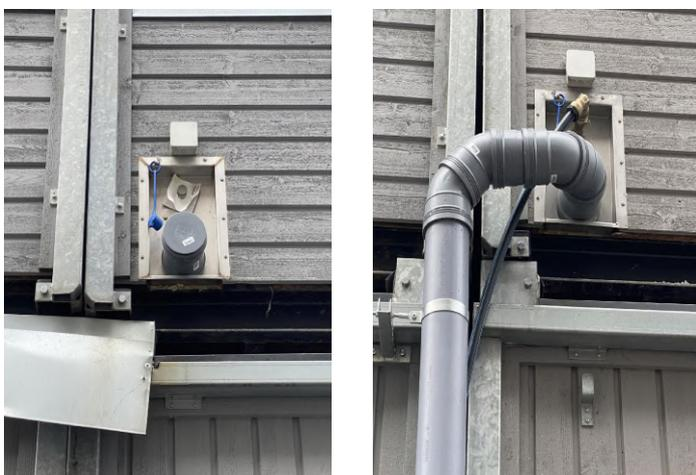
Abbildung 52: Steckverbindung Trinkwasser / Abwasser an Modulen in Malmö (Quelle: Londong/Hörnlein).
