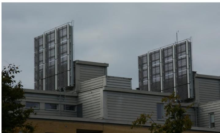
Abbildung 66: Solarkollektoren auf Dächern in Malmö (Quelle: Hörnlein/b.is, 2020).
