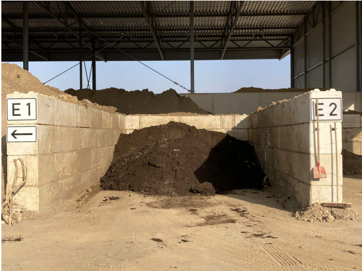
Abbildung 1 - Lagerbox für unbeprobtes Bodenmaterial
