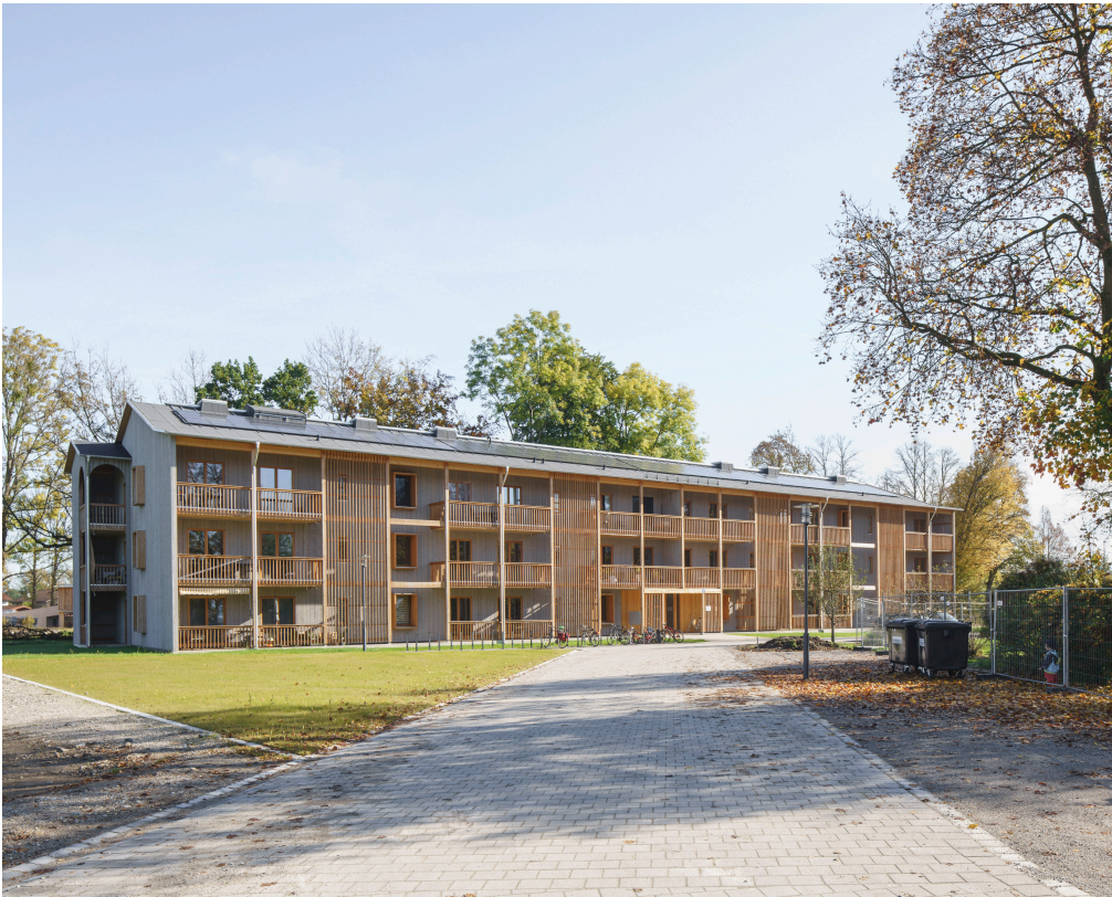
Abbildung 94: Außenansicht. Wohnen in Bad Aibling, Foto: Sebastian Schels
