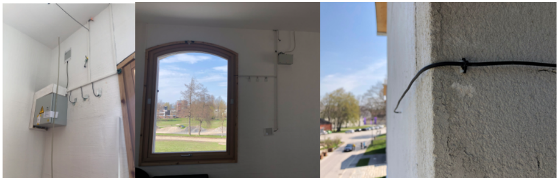
Abbildung 11: links: Messtechnik Westwand, mittig: Nordwand, rechts: Temperaturfühler Oberfläche außen Nordwand Mauerwerksgebäude
