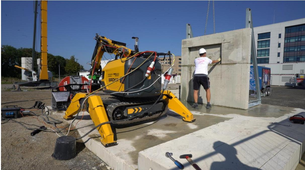
Die Ergebnisse dieser Versuche waren viel versprechend. Ein Bauteil konnte erfolgreich und ohne Beschädigung aus der Betonwand herausgetrennt werden. Die entwickelte Sägevorrückung erwies sich als funktionsfähig und konnte sogar durch Stahlarmierungen schneiden, ohne instabil zu werden. Insbesondere der horizontale Schnitt in Verbindung mit der Feinausrichtung über eine Linearführung stellt einen wichtigen Schritt in Richtung einer (teil-)automatisierten Gewinnung von Betonbauteilen dar.
