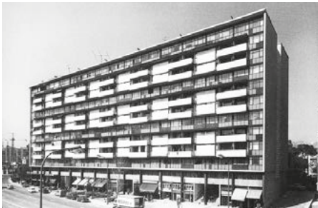
1959-62 Edificio Mitre, ES | B. Corsini
