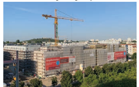
2018-22: Zossenerstraße, DE | ARGE DMSW A.G.
