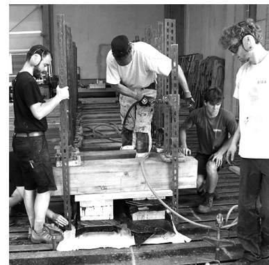
(f) Blockverklebung
