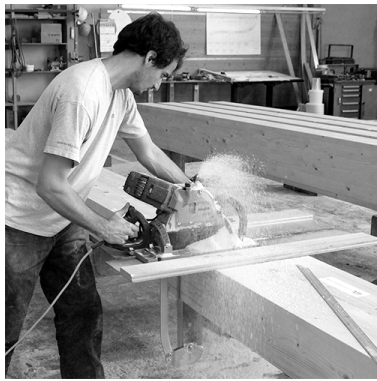
(a) Ablängen der BSH Balken
