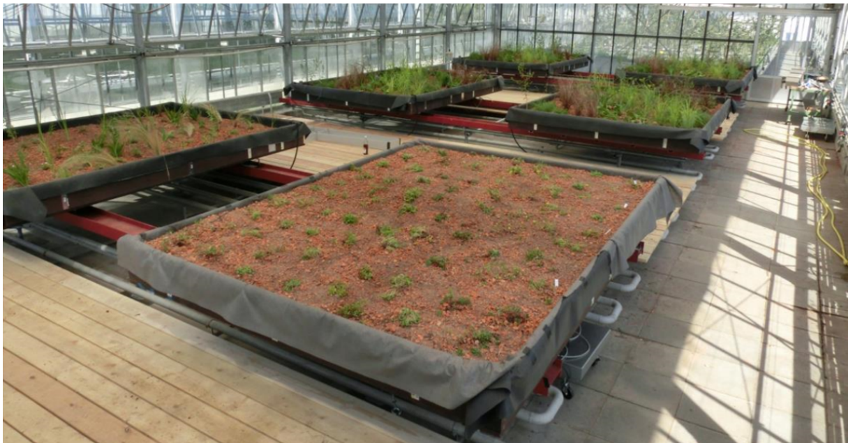
Abb. 5: Dachbegrünungsmodelle kurz nach der Fertigstellung im Sommer 2019 (Quelle: HSWT)
