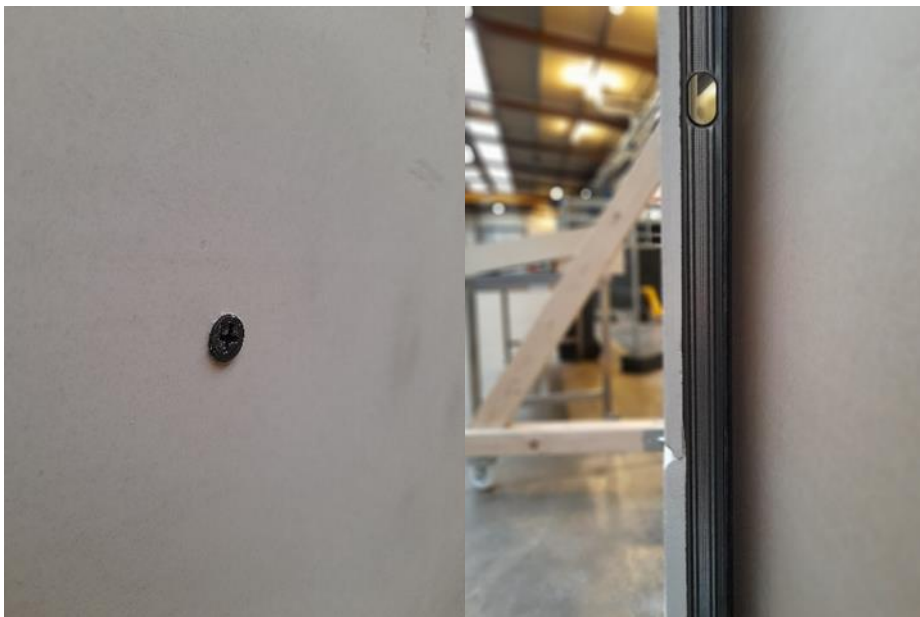
Abbildung 67: Verschraubung einer Platte aus PBGM an einer Unterkonstruktion
