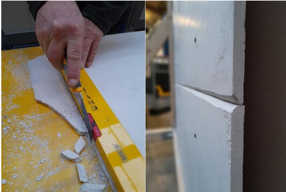
Abbildung 66: Zuschneiden der Demonstratorplatten mit dem Cuttermesser (links) und angefaste Plattenstöße (rechts)
