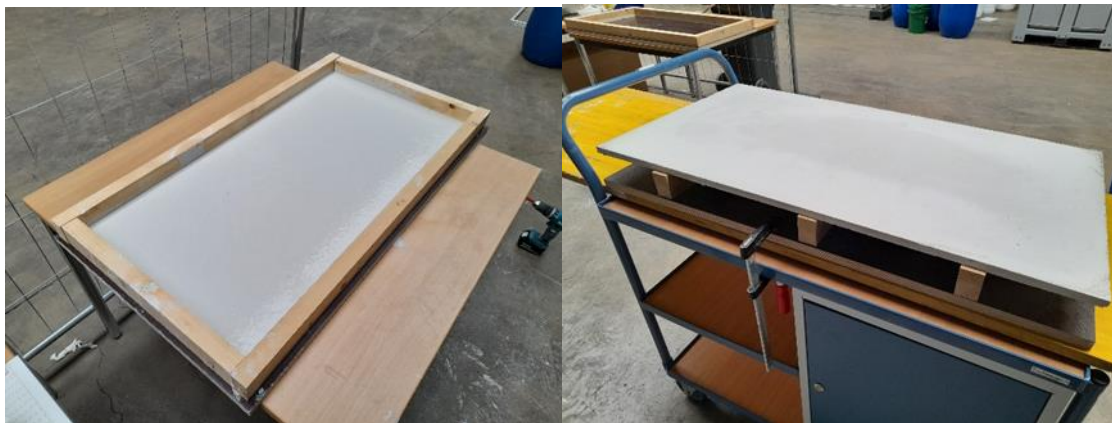
Abbildung 65: Frisch in die Schalung gefüllter PBGM (links) und ausgeschaltete Demonstratorplatte (rechts)
