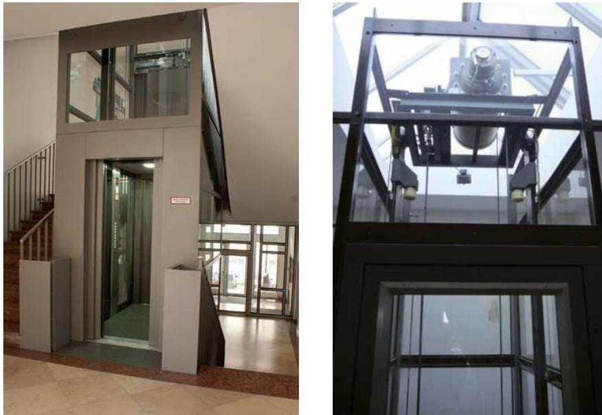
Abbildung 1: nachgerüsteter Aufzug in weitläufigem Treppenhaus (links); Trommelantriebseinheit in einem Schachtkopf (rechts)
