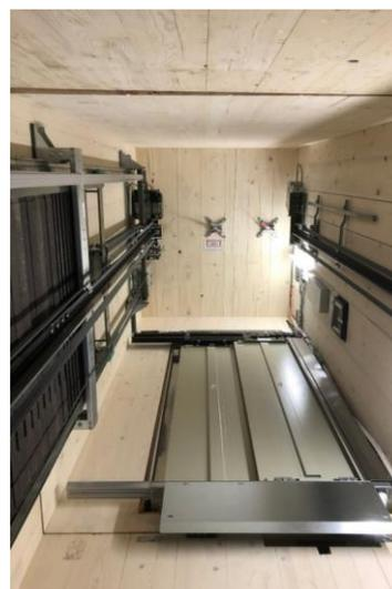
Abbildung 28 (links): Aufzugsschacht aus Holz mit Holzverkleidung im Bereich der Schachttür [32]
