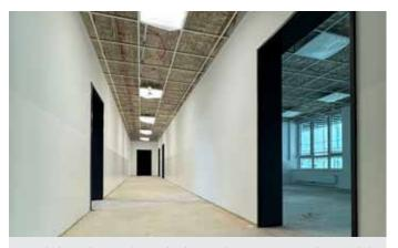
Im Schulverwaltungstrakt wurden bereits die Türzargen eingebaut und die Wände fertiggestellt; Böden und Decke werden in Kürze ausgeführt. (© Stadt Schleiden / Kerstin Wielspütz)
